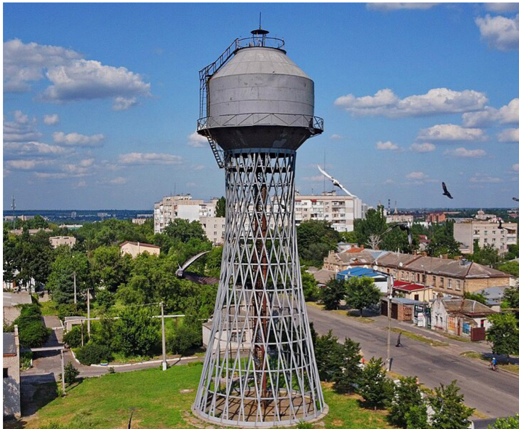
Shukhov Tower Шуховська вежа
